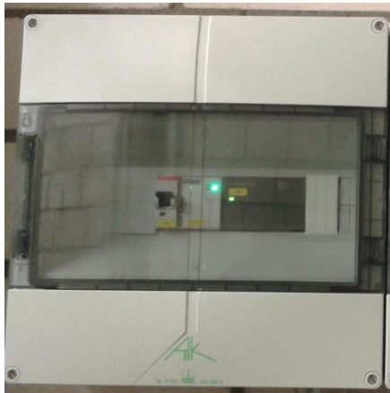
Abb.: EGS ZMD eingebaut in einem Gehäuse inkl. Sicherungen und 24V Spannungsversorgung
